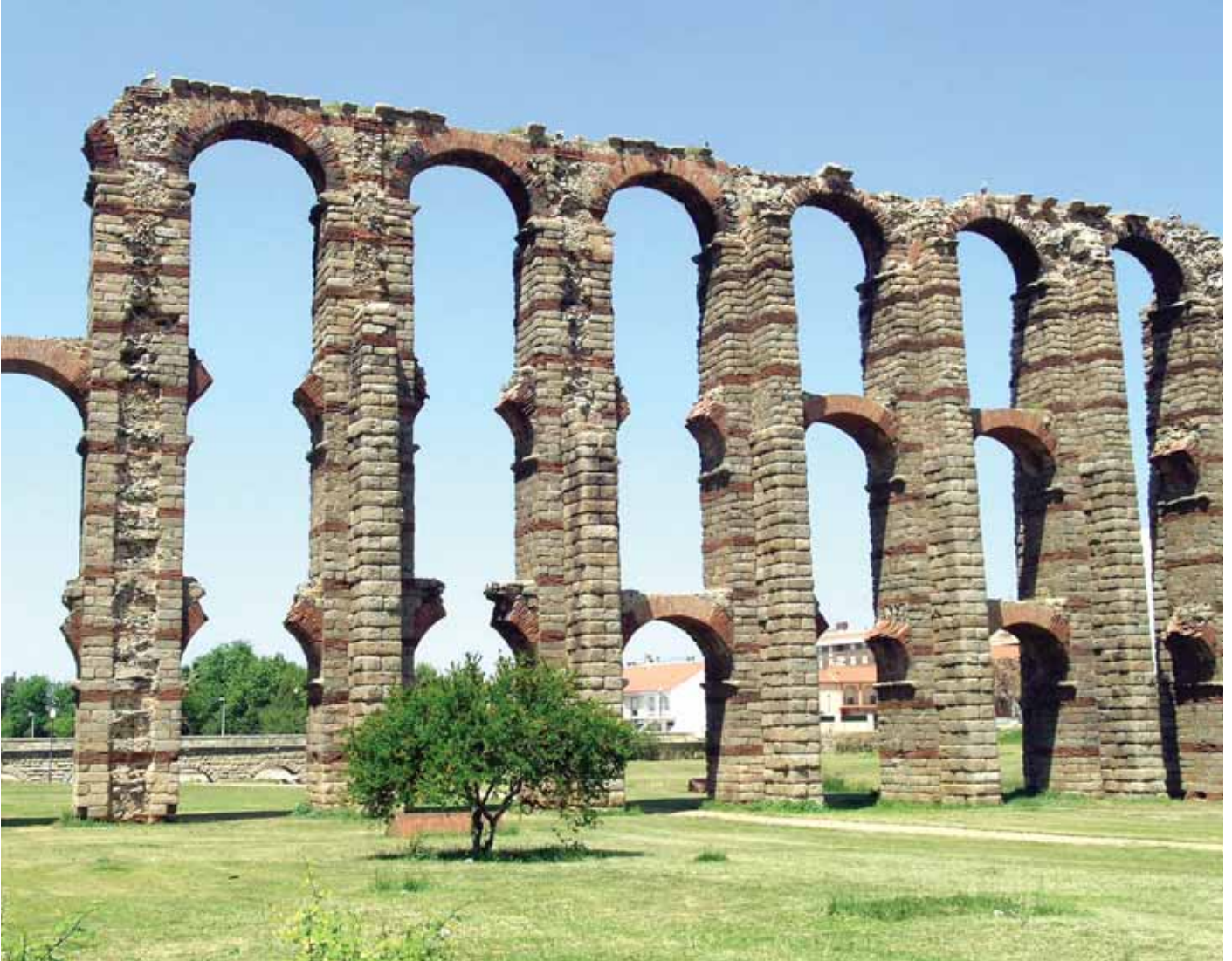
Fig.1. Acueducto de los Milagros (Mérida).
