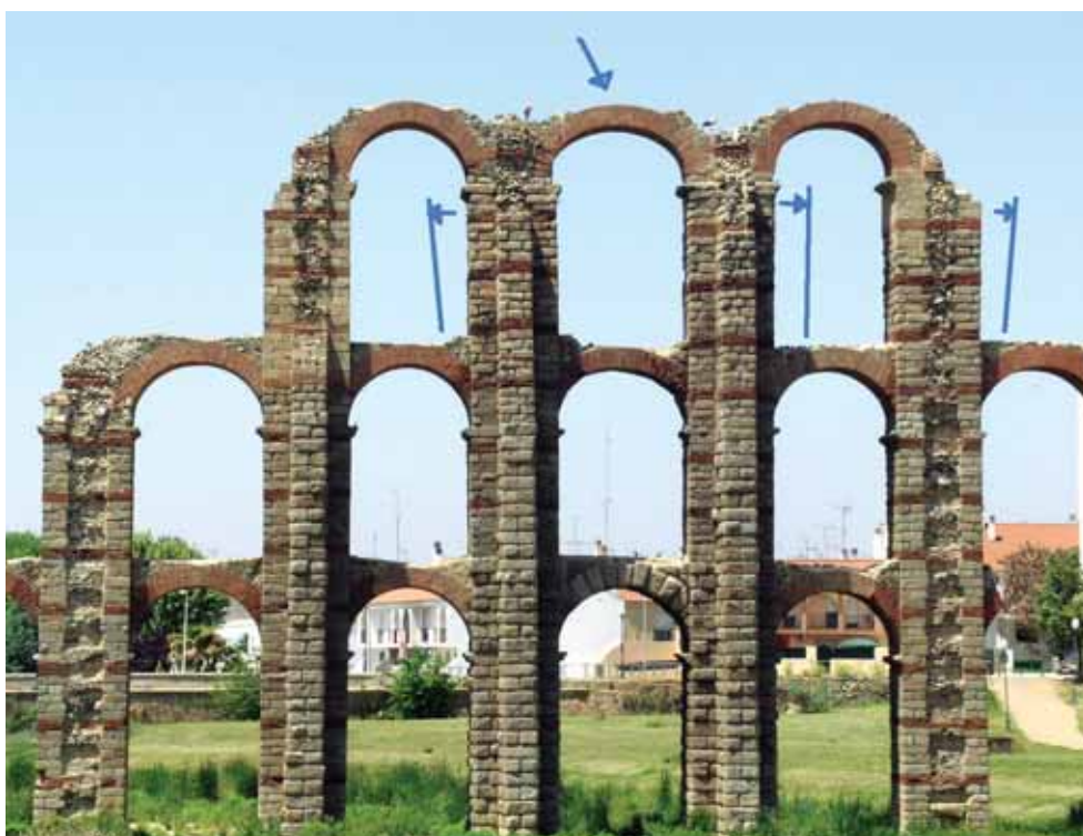
Fig 10. Deformaciones de los pilares debido a la falta de contrarrestos (antes de hacerse la restauración actual).
