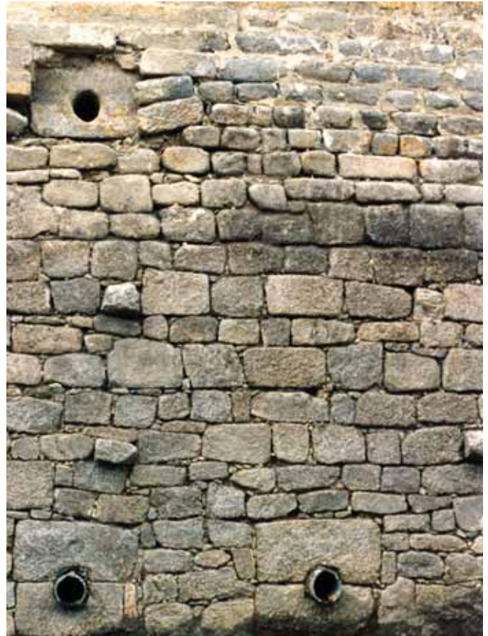
Fig. 19. Primera fase de Proserpina con una sillería completamente irregular.
