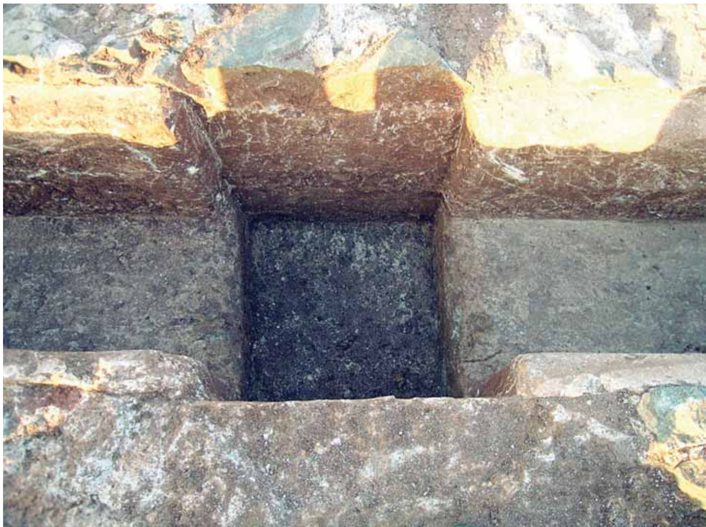
Fig.6. Rebajes en los pozos de registro.
